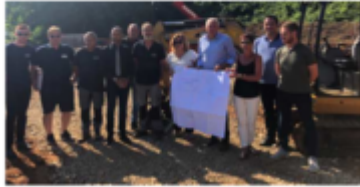
Saverio Luciani, conseiller exécutif et président de l'Office d'équipement hydraulique de la Corse (OEHC), entouré du maire de Tagliu-Isulacciu, Marie-Thérèse Mariotti, et de leurs équipes, sur le chantier du sur-pressur en bordure du Fium'Alto.
