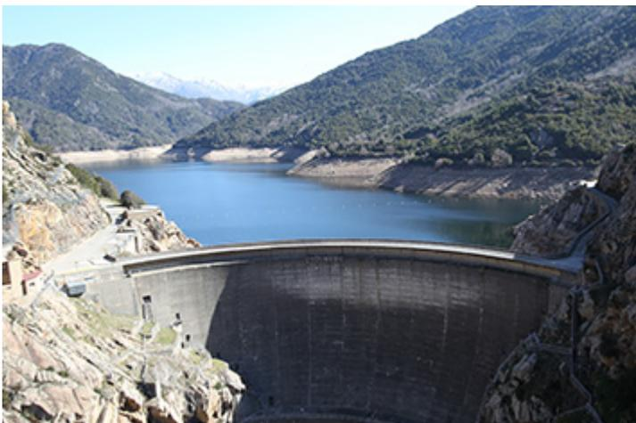
Outre la production énergétique de 42.5 MW, le barrage de Tolla permet, via le bassin de compensation de l'O.E.H.C de 100000 m<sup>3</sup> et de l'usine hydroélectrique du pont de la vanna, l'alimentation en eau potable d'Aiacciu et de la rive sud d'Aiacciu ainsi que l'alimentation d'un réseau d'irrigation de 91 km.
