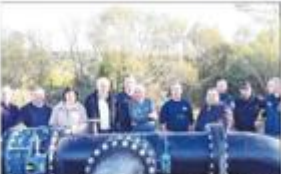
Le projet de construction de la centrale hydroélectrique de la vallée de l'Arce, à la limite de la commune de Sottosanto, est en cours de réalisation.
