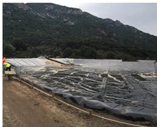
Subissant depuis quelques années de fortes dégradations dues essentiellement au vieillissement de sa géo-membrane, principal élément du dispositif d'étanchéité pour ce type de bassin, il a donc été décidé de procéder à de lourds travaux de réhabilitation, entraînant une indisponibilité de 6 mois.
